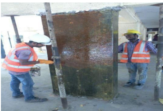
Fig: - Primer on RCC Column
